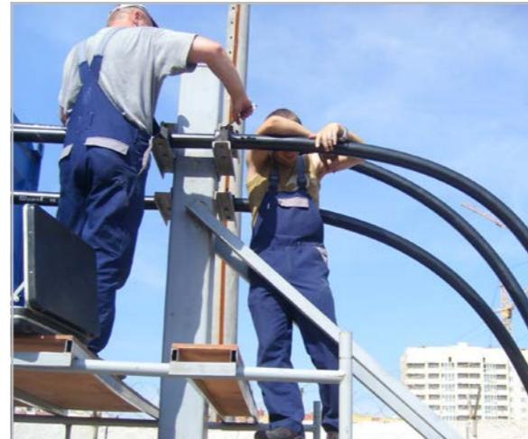
Монтаж кабельной секции МПС 110/10(6) кВ
