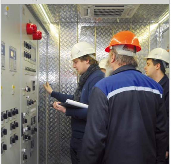
Производственные испытания МПС 220/10 кВ
