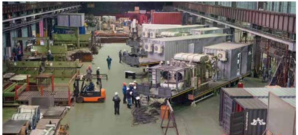
Производственные испытания ММПС 25 МВА 110/20(10) кВ
